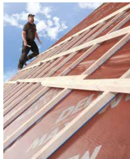
Dank der Selbstkleberänder kann die Bahn unkompliziert und schnell verarbeitet werden.
