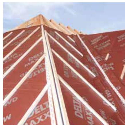
Die hohe Elastizität und Dehnfähigkeit von DELTA®-MAXX WD sorgt für beste Verlegesicherheit.
