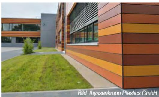
Abb. 8 Fassade aus „brettformatigen“ Elementen mit einer Breite von ca. 150 mm. Die Befestigung erfolgte durch Niete mit Kopflackierung in der jeweiligen Farbe.
