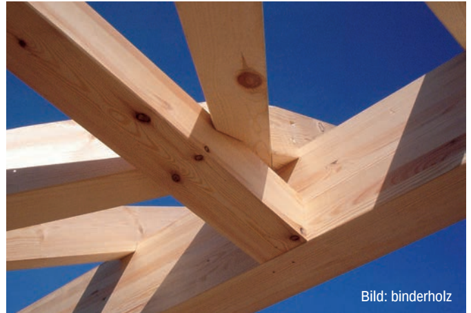
Abb. D3.2 Brett- oder Balkenschichtholz reduziert die Schwindverformungen auf wenige Millimeter. Die Konstruktion ist damit formstabil.
