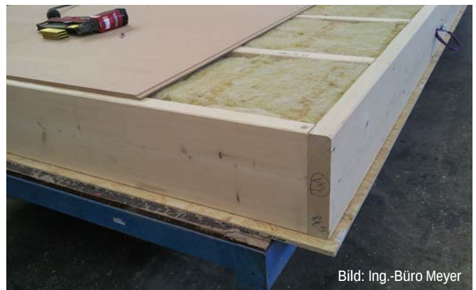
Abb. G2.25 (Stufe 2) Nach dem Wenden wird der Dämmstoff eingebaut und die Unterdeckung aus Holzfaserverplatten hergestellt.
