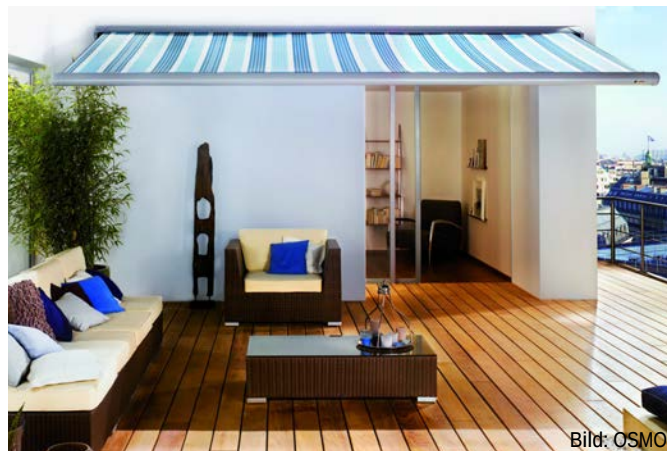
Abb. F4.7 Das Bild zeigt eine wunderschöne Dachterrasse, die den Zusammenhang der Anforderungen aufzeigt. Innenfußboden und Dachterrasse laufen höhengleich durch. Mit der Schiebetür wird ein barrierefreier Zugang zum Freisitz ermöglicht. Allerdings ist diese Lösung mit den Fachregeln nicht ohne weiteres vereinbar.
