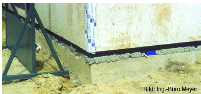
Abb. G1.7 Die Fuge unter der Schwelle nach dem Verfugen mit Quellmörtel.
