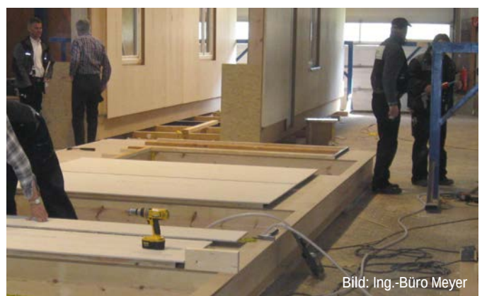
Abb. G2.26 (Stufe 3 und 4) Im Vordergrund wird eine Fassade aus hinterlüfteten Putzträgerplatten montiert. Im Hintergrund ist die Fenstermontage im stehenden Element bereits erfolgt.
