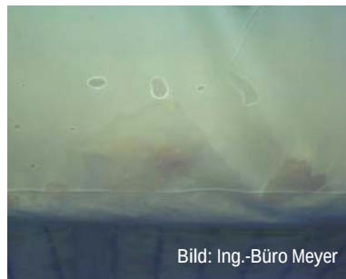
Abb. C4.15 Typische Kondensatbildung an einer sperrenden Kunststoff-Folie im Sommer.
