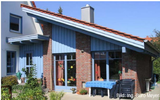
Abb. G5.2 Außenwandanschluss zum Verbindungselement, Ausführung mit Dehnfuge.
