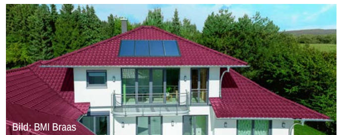
Abb. E1.12 Die Regeldachneigung der ausgewählten Dachziegel beträgt laut Hersteller 16^\circ .
