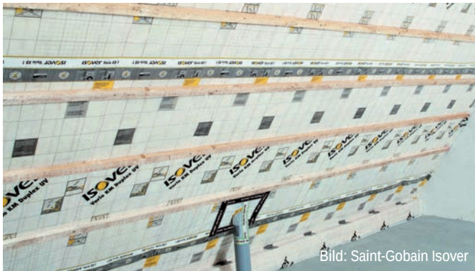
Abb. C2.9 Im Dachgeschoss wurde die Luftdichtung vollständig hergestellt. Es ist anzuraten zu diesem Zeitpunkt eine Abnahme über die fachgerechte Ausbildung der Luftdichtung mit der Bauherrschaft durchzuführen. Ggf. sollte eine vorläufige Differenzdruckmessung durchgeführt werden. Denn nun folgen die haustechnischen Gewerke, die die Luftdichtungsebene durchstoßen und zerstören könnten.
