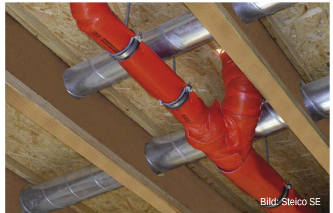
Abb. G2.36 Für die Größe, Anordnung und Abstände von Durchbrüchen im Steg sind die Angaben des Herstellers zu berücksichtigen.
