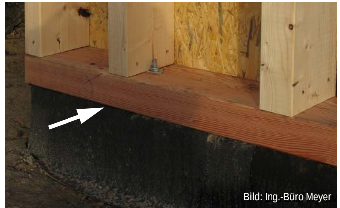
Abb. G1.16 Hier liegt die Schwelle vollflächig auf, der Kraftschluss ist gewährleistet. Dies setzt eine Betonplatte mit einer Höhentoleranz von \pm 5 mm voraus.
