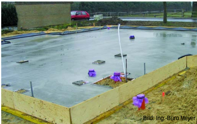
Abb. G1.15 Vor dem Betonieren sollte die richtige Position der Anschlussleitungen überprüft werden. Fehlerhaft positionierte Grundleitungen verursachen einen hohen Aufwand und Qualitätsverlust.
