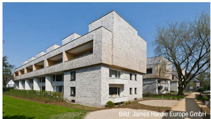
Abb. C6.23 Durch eine Aufstockung eines zweigeschossigen Wohngebäude kann die Gebäudeklasse 4 erreicht werden. Dies gilt dann für das gesamte Gebäude.
