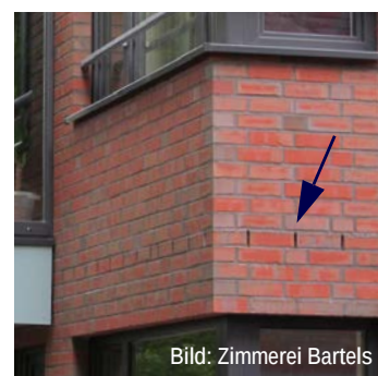
Abb. C5.24 Die Ausbildung der Zu- und Abluftöffnungen in der Mauerwerk-Vorsatzschale erfolgt als offene Stoßfugen in der 2. bzw. 3. Schicht oberhalb der Z-Folie.
