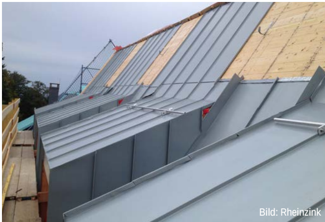
Abb. E1.29 Auf den Hauptdachflächen wurde die Stehfalzdeckung direkt auf der Schalung verlegt. Auf den flachgeneigten Gauben sorgt eine strukturierte Trennlage für die Abführung eventuell eingedrungener Feuchtigkeit.
