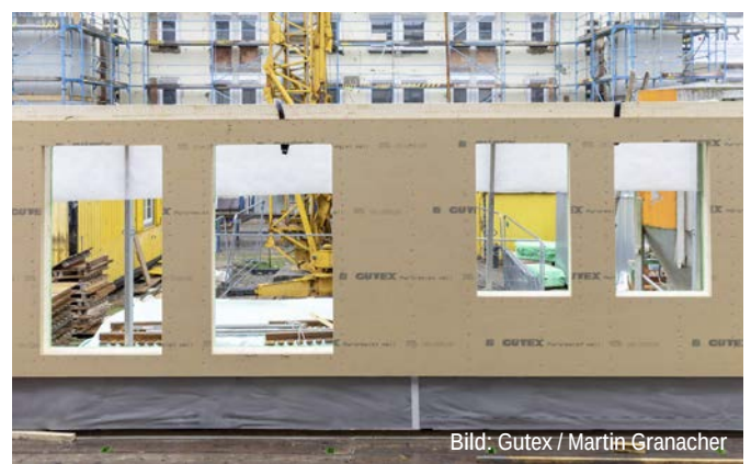
Abb. C6.28 Außenwand einer Dachaufstockung mit schwer entflammbarer Holzfaserdämmplatte.
