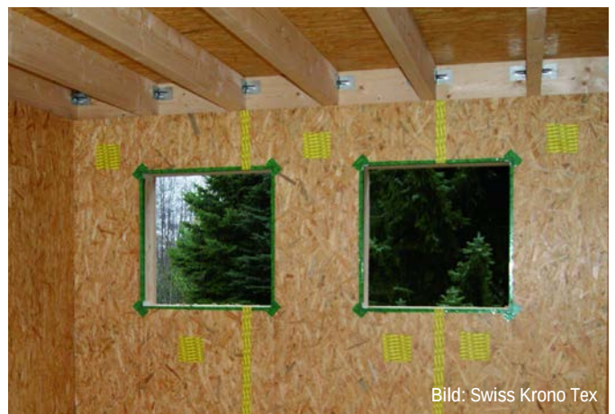
Abb. C2.8 Luftdichtheitsebene aus OSB-Platten mit verklebten Plattenstößen und Fensteranschlüssen. Bei höheren Anforderungen an die Luftdichtheit sollten OSB-Platten mit geprüfter Luftdichtheit eingesetzt werden.
