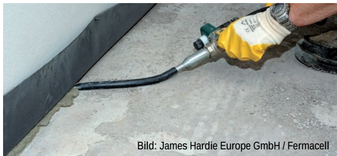
Abb. G1.6 Nach der Wandmontage wird die Fuge zur Bodenplatte vollflächig mit Quellmörtel (!) verfüllt.
