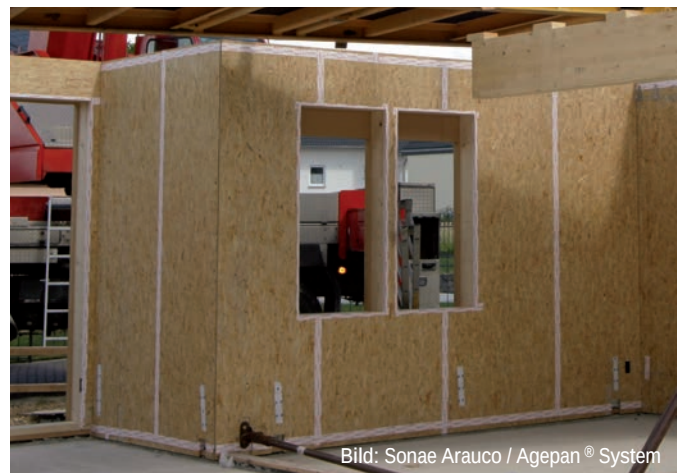
Abb. G2.10 Die Innenbeplankung im Holzrahmenbau erfolgt sehr effizient mit großformatigen OSB-Platten im geschosshohen Format. Plattenmaße: 2,65 m und 2,80 m für die aufliegende Geschossdecke 3,00 m für die eingehängte Decke
