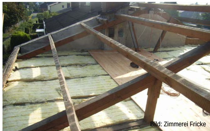
Abb. G4.4 Bestandskonstruktion, Untergurt des vorhandenen Nagelplattenbinders.
