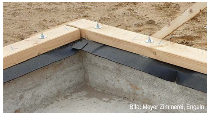
Abb. C4.18 Bitumenbahn als Trennlage zwischen Schwelle und Betonaufkantung.
