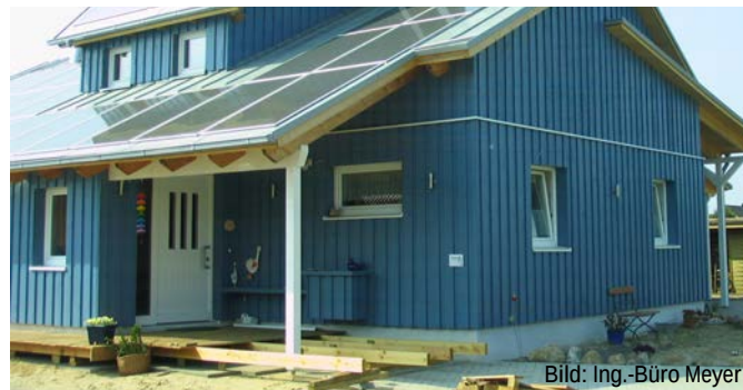
Abb. F1.3 Mit dem Vordach und einem Holzpodest wird nicht nur der Komfort im Bereich des Hauseingangs erhöht. Von großer Bedeutung für den Holzschutz ist, dass der Sockel des Hauses „trockengelegt“ wird.
