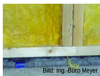
Abb. G1.11 Deutlich zu erkennen ist die Qualität einer mit Quellmörtel vollflächig unterfütterten Schwelle. Die lastabtragende Doppelstütze hat ein perfektes Auflager. Ebenfalls ist vor dem Aufsetzen der Innenwand der Rauch- und Schallschutz von Raum zu Raum gewährleistet.
