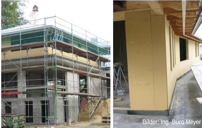
Abb. G3.7 Die unteren Geschosse wurden als Mauerwerk mit Betondecken erstellt, das Staffelgeschoss in Holzbauart.
