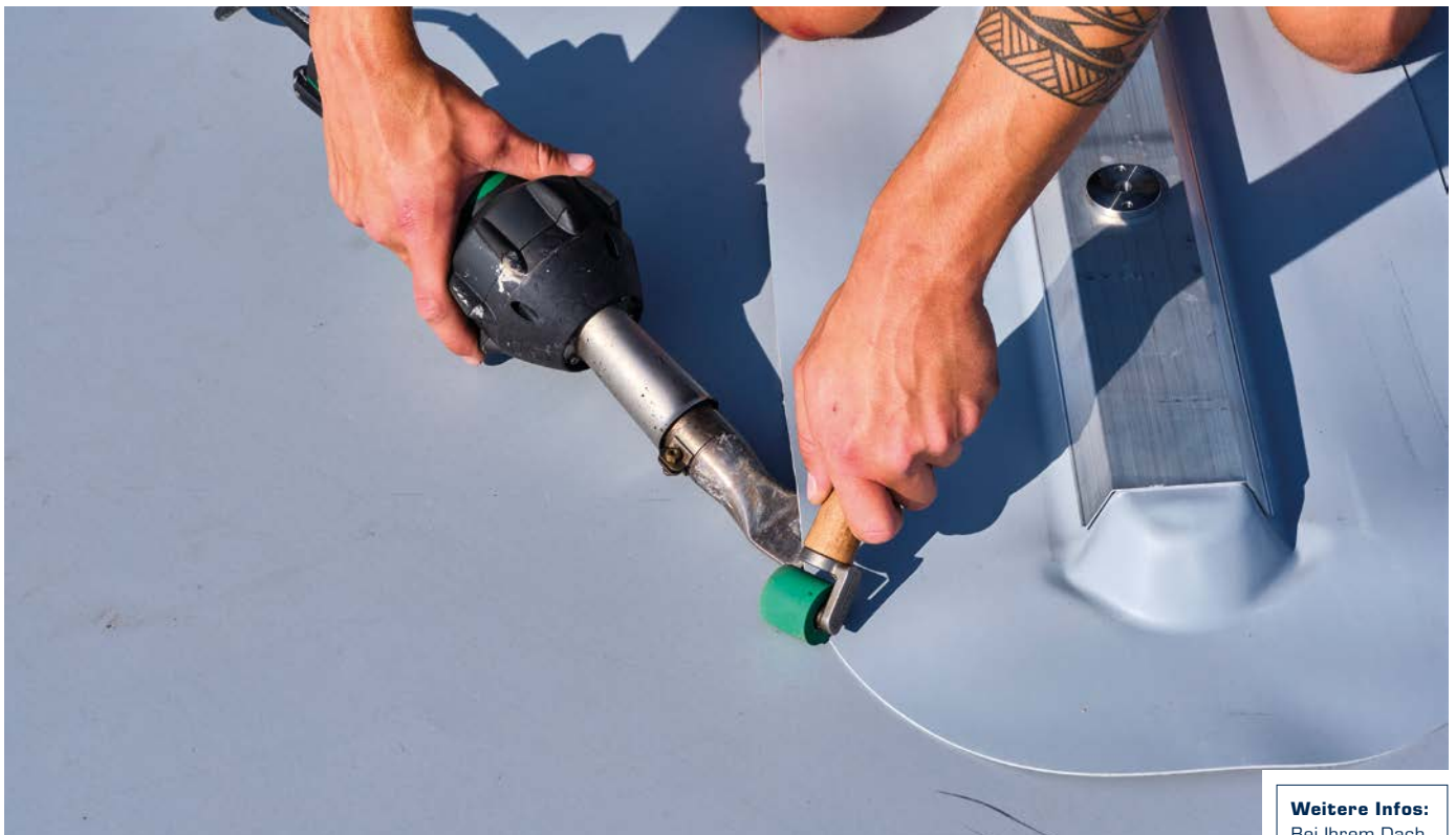
Mit EVATEC® Solar erweitert alwitra das System bis zur Photovoltaikbefestigung. Die Montageschiene ist auf den geprüften Dachaufbau abgestimmt und vermeidet zusätzliche, nicht systemkonforme Bauteile. Foto: alwitra/Sven-Erik Tornow
