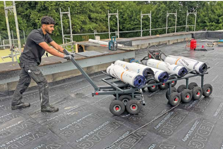
Der Dachtransportwagen Tausendfüßler in luftbereifter Variante
