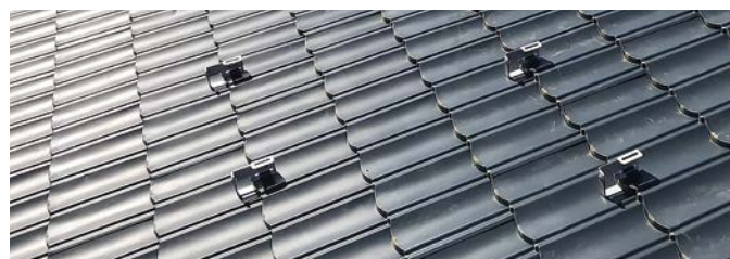
Solarhalter auf Metalldachplatte in Ziegeleoptik
