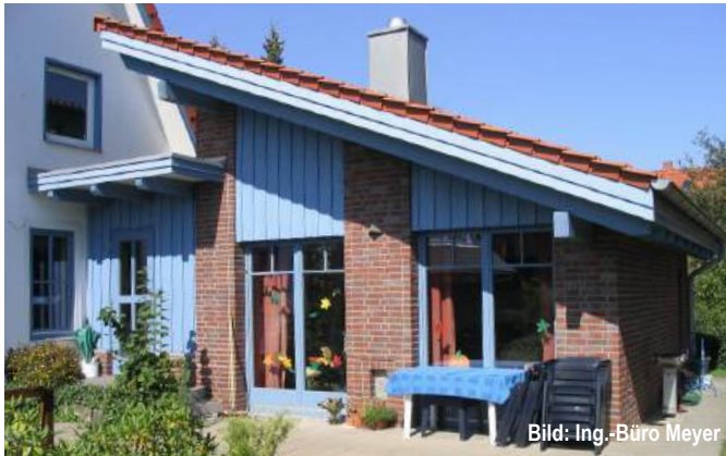
Abb. G6.1 Die Verbindung des Anbaus zum Bestandsgebäude erfolgt über einen schmalen verglasten Verbindungsgang. Eine bautechnisch sinnvolle und gestalterisch ansprechende Lösung. Ausführung im Detail siehe Abb. G6.2
