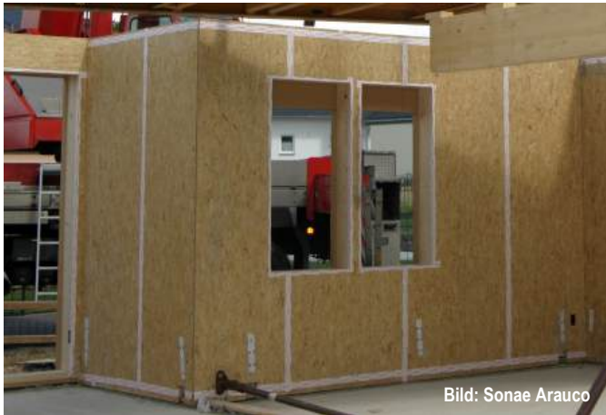
Abb. C8.23 Die Innenbeplankung im Holzrahmenbau erfolgt sehr effizient mit großformatigen OSB-Platten im geschosshohen Format
