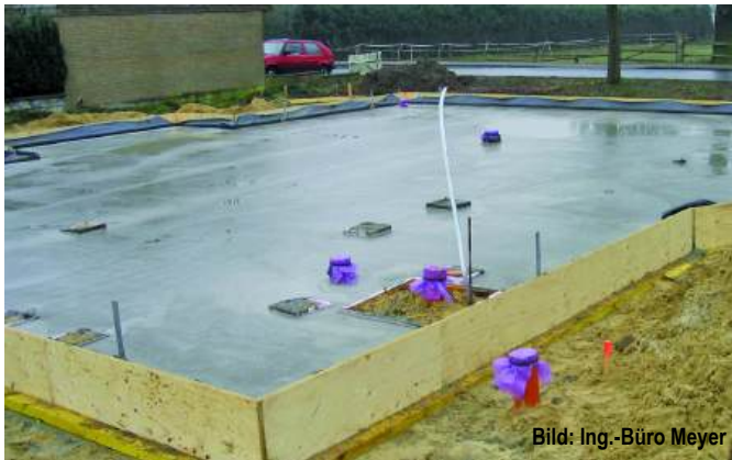
Abb. G2.16 Vor dem Betonieren sollte die richtige Position der Anschlussleitungen überprüft werden. Fehlerhaft positionierte Grundleitungen verursachen einen hohen Aufwand und Qualitätsverlust.
