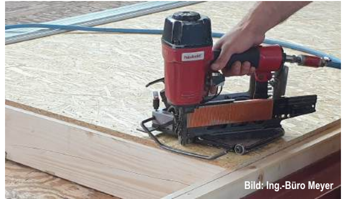
Abb. C8.26 Führungsvorrichtung zum Einhalten der Randabstände
