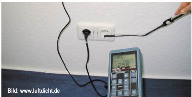
Abb. C2.7 Hier das Beispiel einer Steckdose, die beim Einbau nicht abgedichtet wurde. Diese kleine Leckage auf der Raumseite der Wand genügt, um schleichend für eine Wasseransammlung in der Wand zu sorgen.
