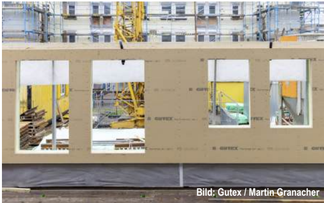
Abb. C6.27 Außenwand einer Dachaufstockung mit schwer entflammbarer Holzfaser-Dämmplatte
