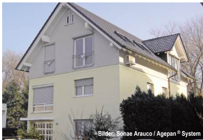
Abb. C1.13 Bei der energetischen Modernisierung von bestehenden Gebäuden werden die gleichen Rechenverfahren verwendet wie beim Neubau. Der Wärmeschutznachweis erfolgt nach dem Gebäudeenergiegesetz GEG (Bilder zeigen Aufstockung mit Fassadensanierung).
