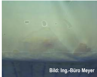
Abb. C4.16 Typische Kondensatbildung an einer sperrenden Kunststoff-Folie im Sommer
