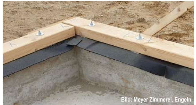
Abb. C4.22 Bitumenbahn als Trennlage \uparrow zwischen Schwelle und Betonaufkantung.
