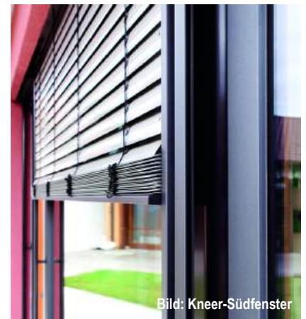
Abb. C1.29 Außenraffstores bieten einen sehr wirksamen Schutz vor Sonneneinstrahlung, siehe Abminderungsfaktoren in Tab. C1.30.
