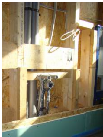
Abb. E7.6 Das Rahmenwerk musste hier mittels Latten „aufgedoppelt“ werden, um die Rohrleitungen unterbringen zu können. Am rechten Bildrand ist im Anschnitt ein Installationsmodul zu erkennen.
