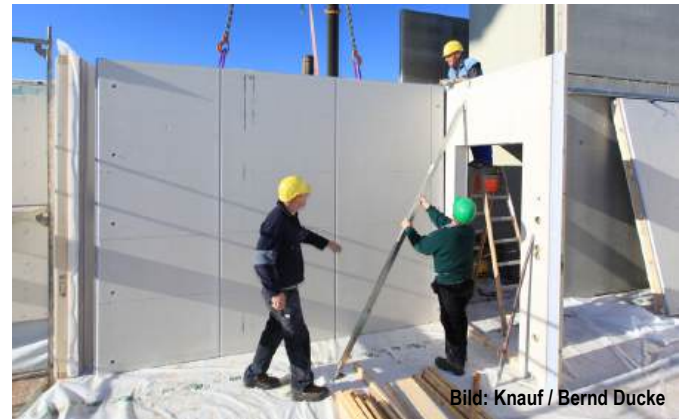
Abb. C6.30 Rauntrennende Innenwände in hochfeuerhemmender Ausführung
