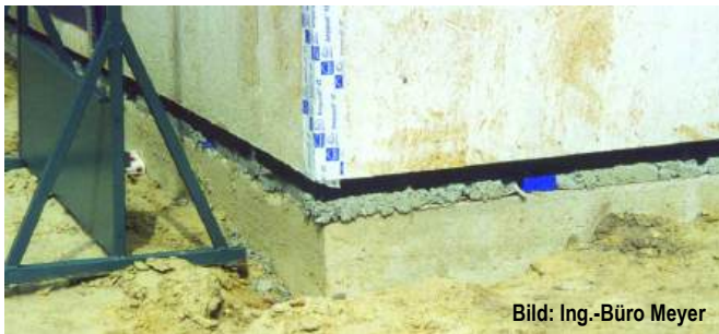
Abb. G2.7 Die Fuge unter der Schwelle nach dem Verfugen mit Quellmörtel
