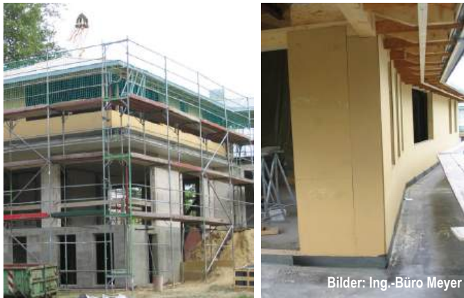
Abb. G4.7 Die unteren Geschosse wurden als Mauerwerk mit Betondecken erstellt, das Staffelgeschoss in Holzbauart.
