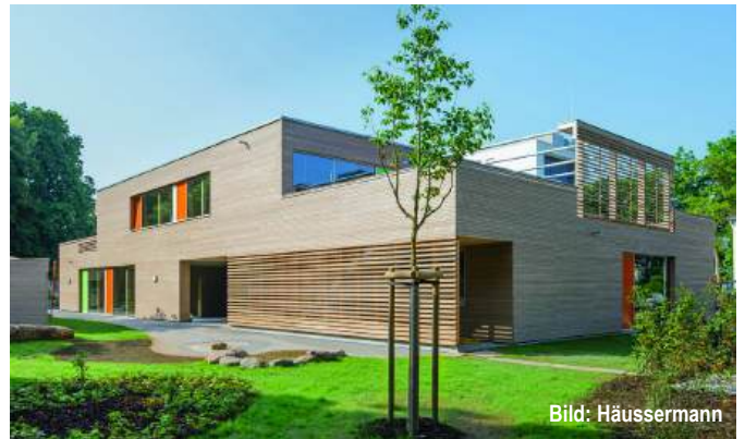
Abb. C6.7 Kita in Holzmassivbauweise in der Gebäudeklasse 3. Da es sich um einen unregulierten Sonderbau handelt, ist ein Brandschutzkonzept zu erstellen.
