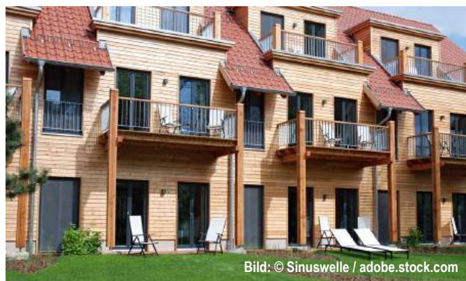
Abb. F6.4 Bei mehr als einer Wohn- und Nutzungseinheit müssen Balkone über Terrassen oder übereinanderliegende Balkone als geschlossene Konstruktion ausgeführt werden.
