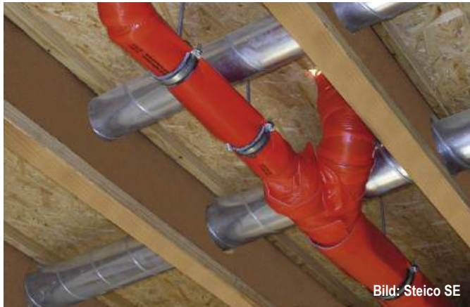
Abb. E7.10 Für die Größe, Anordnung und Abstände von Durchbrüchen im Steg sind die Angaben des Herstellers zu berücksichtigen.
