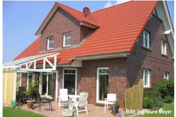
Abb. F1.8 Gebäude mit Verblender sehen robust aus. Dies gilt nicht unbedingt in Bezug auf Feuchtigkeit. Am Sockel kann sehr viel Wasser sein.
