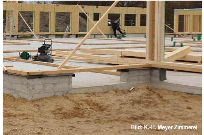
Abb. F1.11 Sockeldetail mit gemauerter Aufkantung
