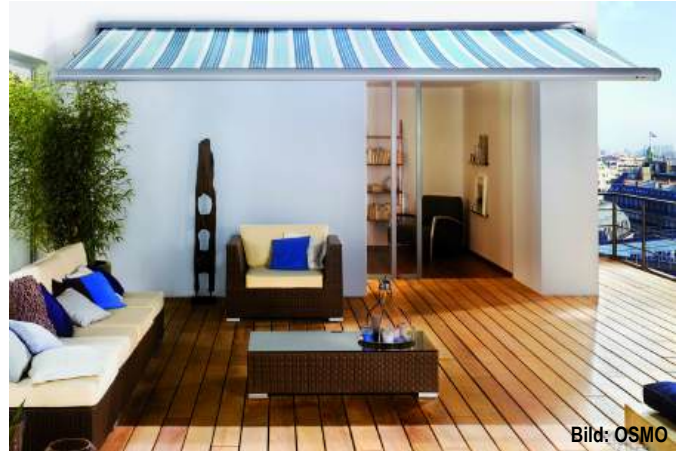
Abb. F6.7 Das Bild zeigt eine wunderschöne Dachterrasse, die den Zusammenhang der Anforderungen aufzeigt. Innenfußboden und Dachterrasse laufen höhengleich durch. Mit der Schiebetür wird ein barrierefreier Zugang zum Freisitz ermöglicht. Allerdings ist diese Lösung mit den Fachregeln nicht ohne Weiteres vereinbar.
