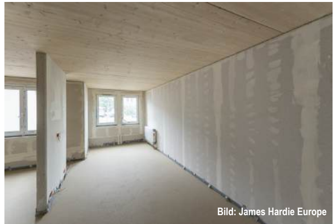
Abb. C6.34 Eine Holzmassivdecke darf sichtbar bleiben, wenn die Brutto-Grundfläche der Nutzungseinheit nicht größer als 200 m 2 ist.
