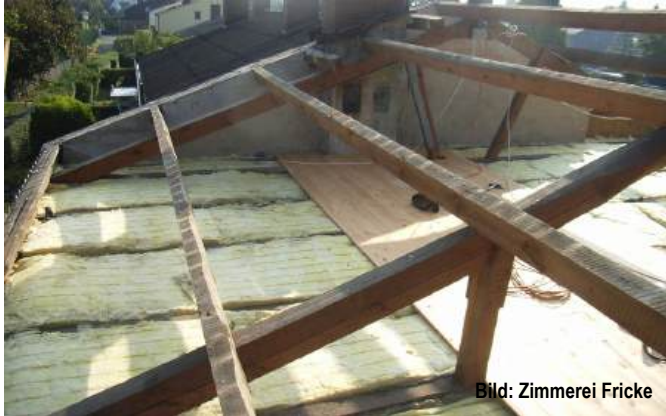
Abb. G5.4 Bestandskonstruktion, Untergurt des vorhandenen Nagelplattenbinders
