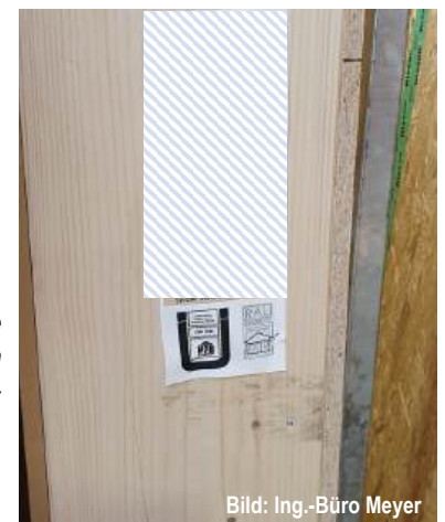
Abb. G3.1 Auf dem Element wird die Konformität mit den Bauregeln mit dem Ü-Zeichen dokumentiert.
