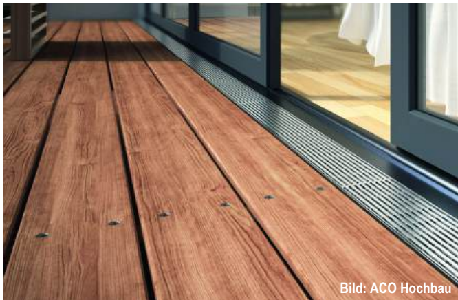
Abb. F6.10 Holzdielen mit Fugen sind als Belag zu sehen, von dessen Oberkante die Abdichtungshöhe zu bemessen ist. Ein barrierefreier Zugang, wie im Bild zu sehen, stellt immer eine Sonderlösung dar.
