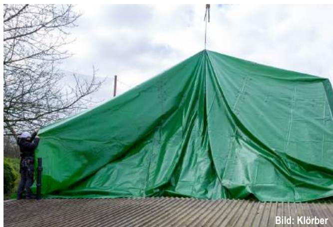
Abb. E3.20 Auch das ist eine Möglichkeit einer Behelfsdeckung. Auf der Baustelle wird eine großformatige Abdeckplane vorgehalten.
