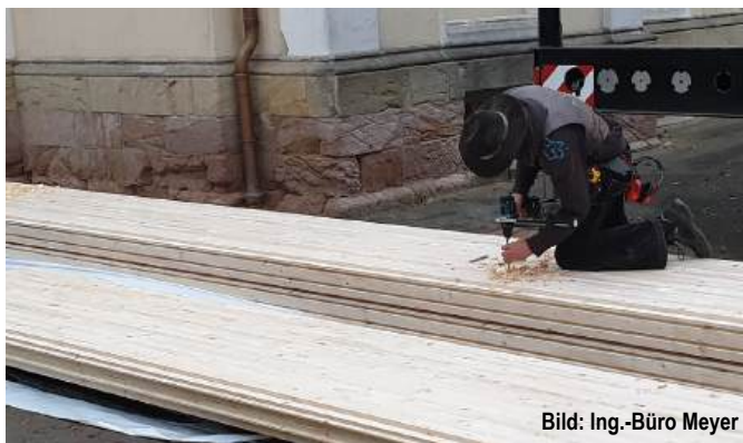
Abb. E2.4 Hier wurden die Elemente vor der Montage zwischengelagert. Der Zimmerer befestigt die Anschläge für die Kranmontage.
