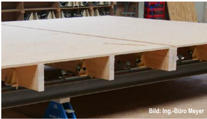
Abb. E2.10 Auslegen einer Großfläche nach Verfahren 1. Der Elementstoß ist zu erkennen.
