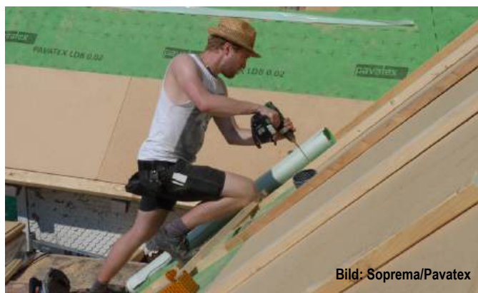
Abb. B1.1 Dachsanierung im Altbau, Montage von Holzfaserdämmplatten.
