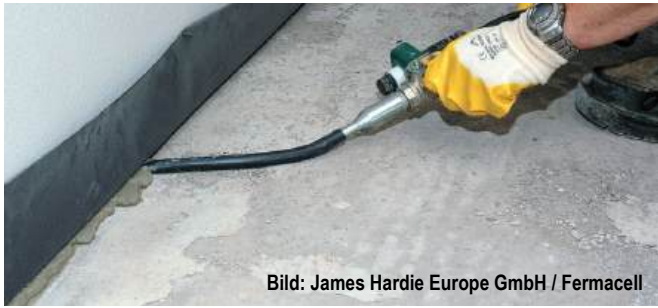
Abb. G2.6 Nach der Wandmontage wird die Fuge zur Bodenplatte vollflächig mit Quellmörtel (!) verfüllt.
